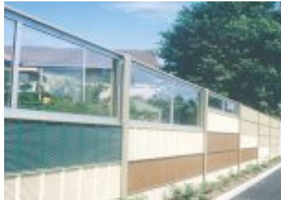
Lärmschutzwand an Strasse Noise barrier wall at a road
