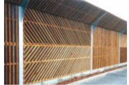
Lärmschutzwand an Parkplatzzufahrt Car park
