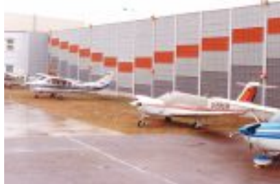
Lärmschutzwand an Flughafen Airport
