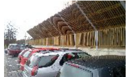
Lärmschutzwand an Supermarkt Supermarket
