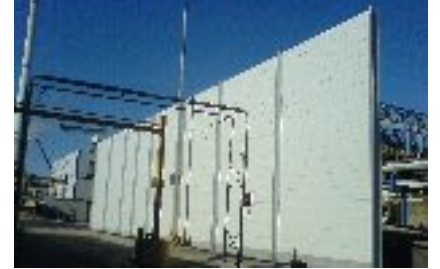
Lärmschutzwand an Industriebetrieb Industrial facility
